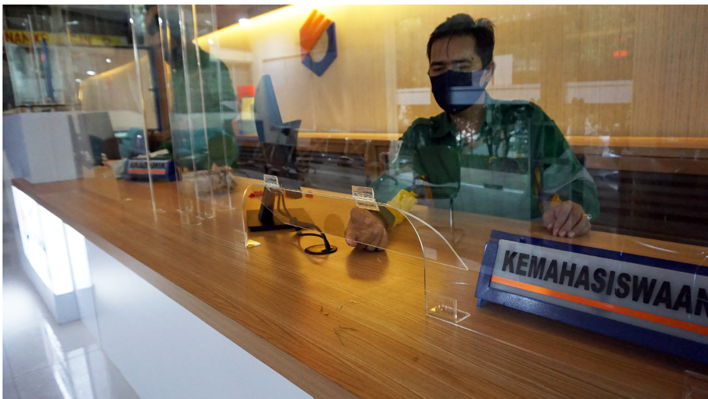
Pemasangan Partisi Akrilik oleh Tim Instalasi PT Safety Sign Indonesia
